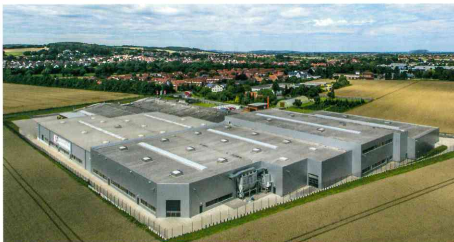
Luftaufnahme des Werks in Rodenberg
