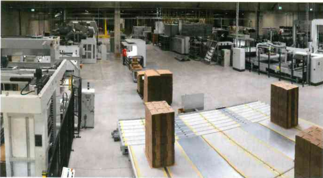
Effizientere Arbeitsabläufe nach der Modernisierung (2)
